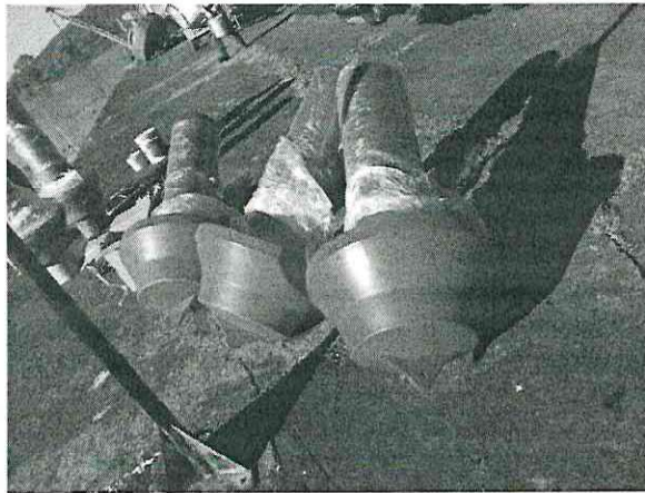
Boyas rojas antes de ser instaladas
